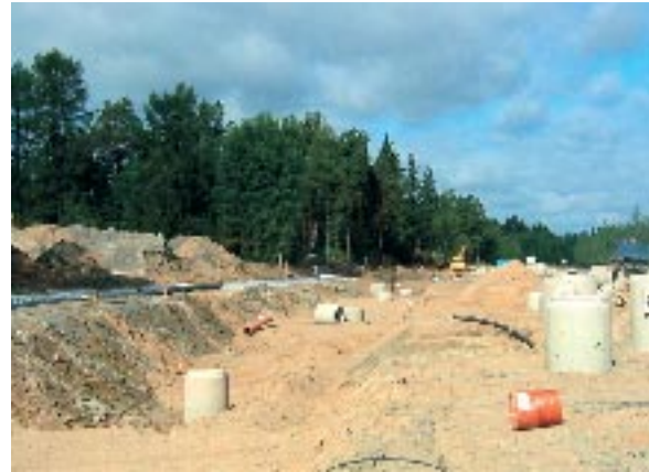
Toppilansaaren asuntomessualueen vesihuoltoverkostojen rakentaminen on käynnissä.
