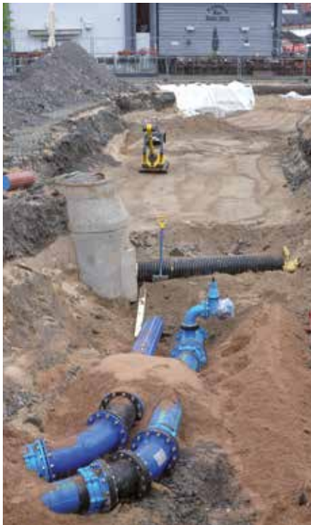
Kivisydämen johtosiirtoja rakennetaan Torinrannassa kesällä 2012.
